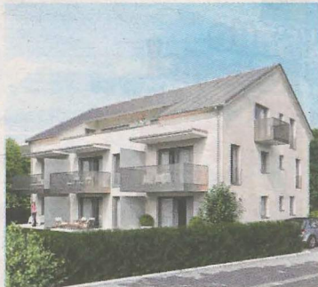
Acht neue Wohnungen in Adnet im Bau.
